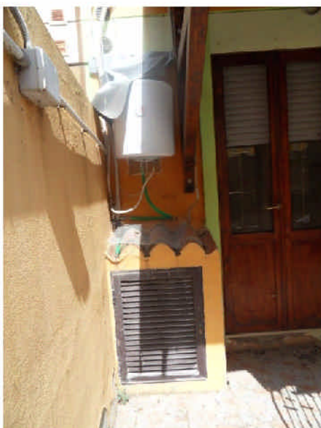
Foto 11: Boiler elettrico
